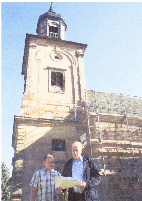
Architekt Onno Folkerts (r.) und Bauleiter Kai Misera sprechen Details des Holzschutzgutachtens durch. Es ist die Basis für die in wenigen Tagen an der Ahlsdorfer Kirche beginnenden Sanierungsarbeiten. Foto: sk Foto: sk
